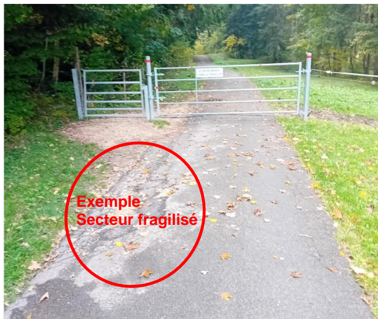
Figure 7 Chemin d'accès état actuel
